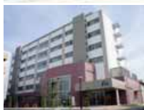
信州ファイバーイノベーション・インキュベーション施設
